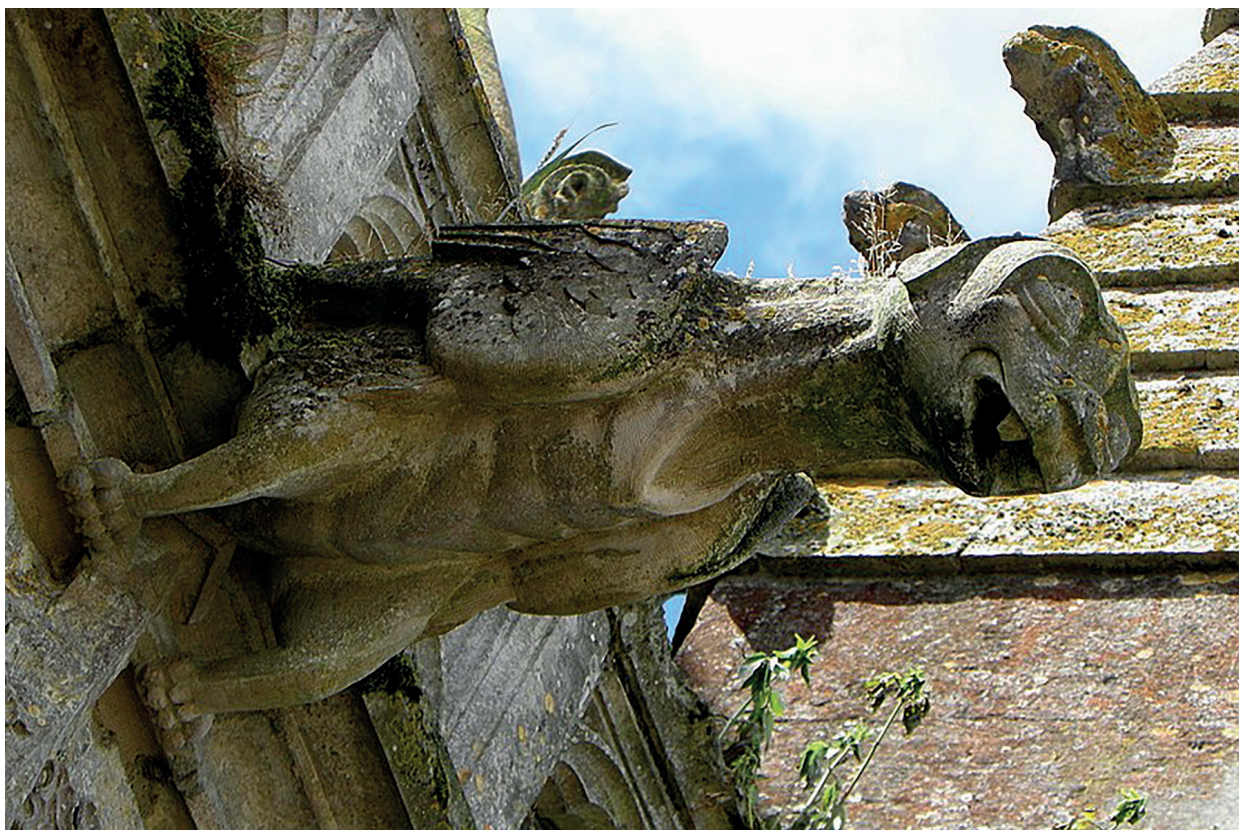
Gargouille d'évacuation des eaux de pluie à la chapelle des Hospices à Ménigoute
