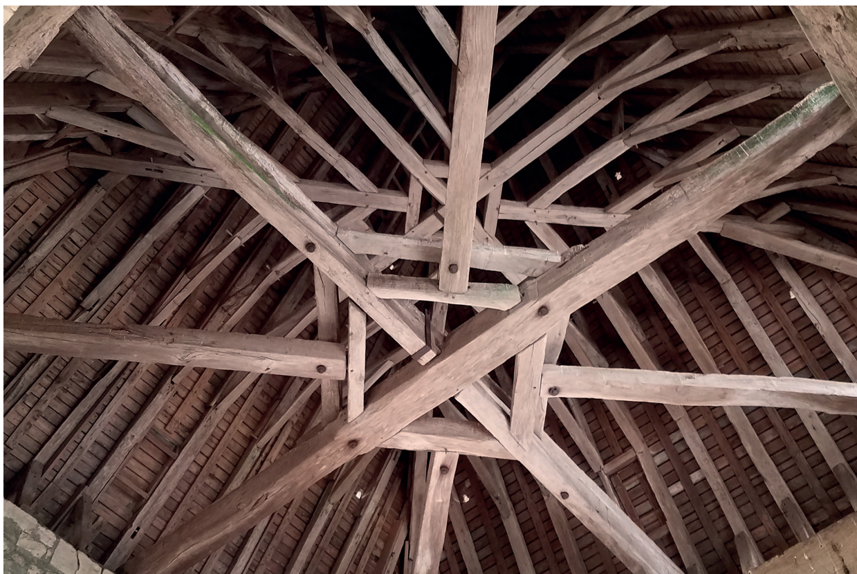
Charpente du clocher de l'église Notre-Dame de Celles-sur-Belle
