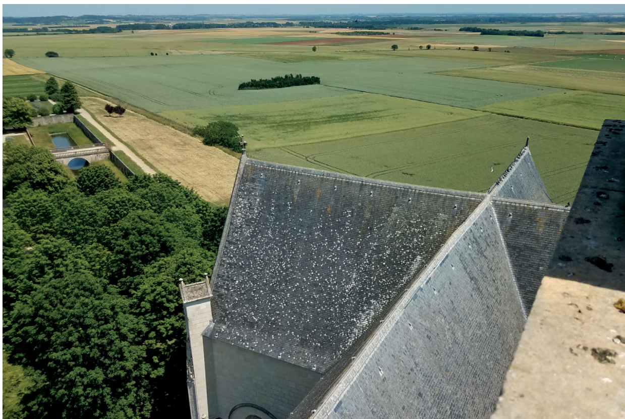
Toitures de l'église Saint-Maurice d'Oiron, Plaine-et-Vallées
